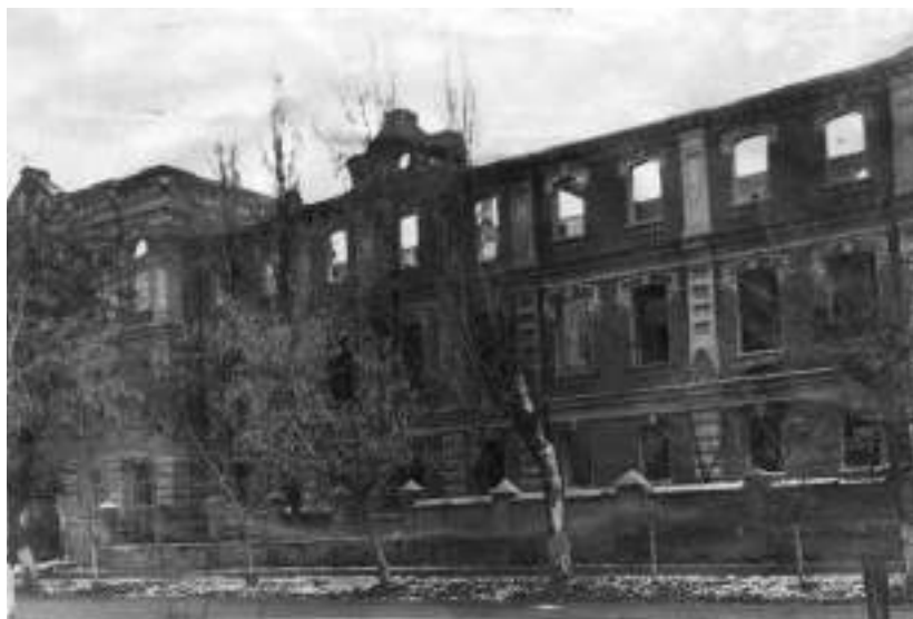
Разрушенное здание Кубанского медицинского института. 1943 год
