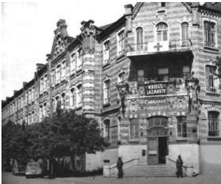
Немецкий госпиталь в Краснодаре на углу улиц Седина и Буденного. 1942 год
