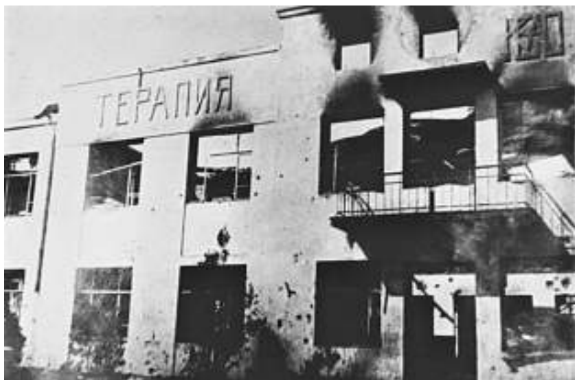
Разрушенное здание терапевтического отделения больницы в Нальчике. 1943 год
